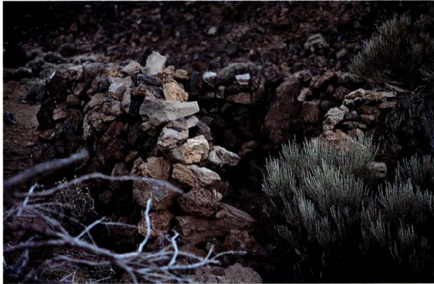
CABAÑA CON MUROS DE PIEDRA SECA Y CUBIERTA VEGETAL. LAS CAÑADAS, TENERIFE. Foto P. Atoche.
